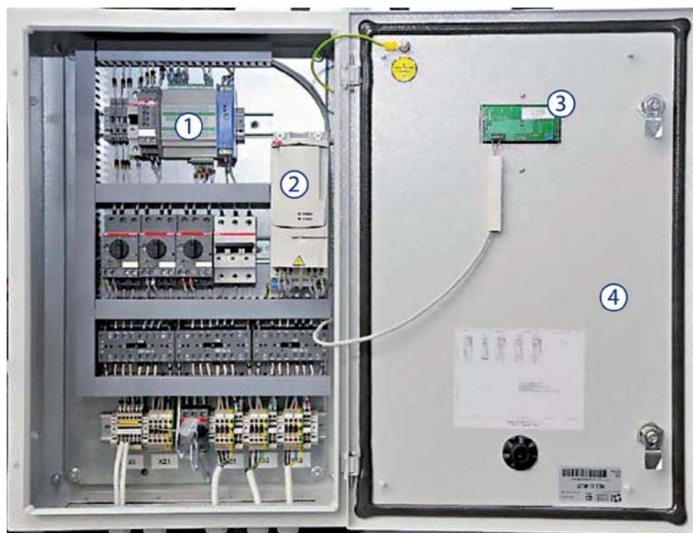
**1 СПЕЦИАЛИЗИРОВАННЫЙ ПРОГРАММИРУЕМЫЙ КОНТРОЛЛЕР ПЛК, РАЗРАБОТАН ДЛЯ УПРАВЛЕНИЯ АВТОМАТИЧЕСКИМИ НАСОСНЫМИ УСТАНОВКАМИ**
