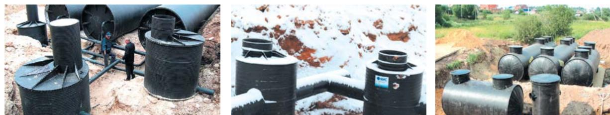
жения. Конструкция выходных патрубков обеспечивает направление всего потока на очистные сооружения при рабочем режиме, а при интенсивном сбросе «условно чистая» часть стока поступает на обводную линию, минуя очистное оборудование и не допускает его перегрузки. Использование распределительного колодца снижает стоимость оборудования для очистки стоков по сравнению с традиционно используемыми системами очистки.
