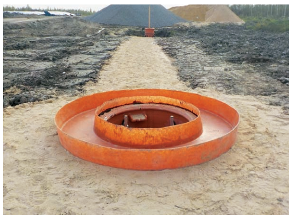
Рисунок: Фото формы под заливку опорного кольца №2 (ФБ2)
