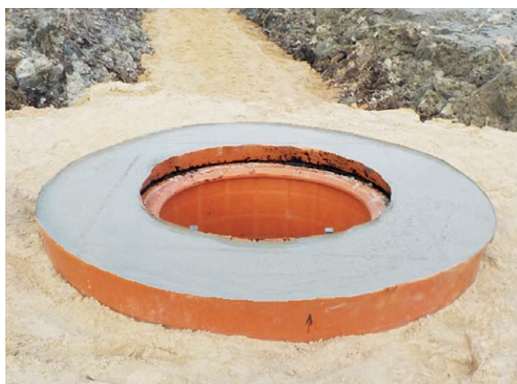
Рисунок: Фото формы под заливку опорного кольца №2 (ФБ2)
