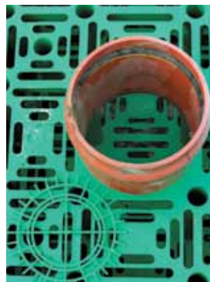
Соединение раструбного перехода диаметром 200 мм в с верхней стенкой блока
